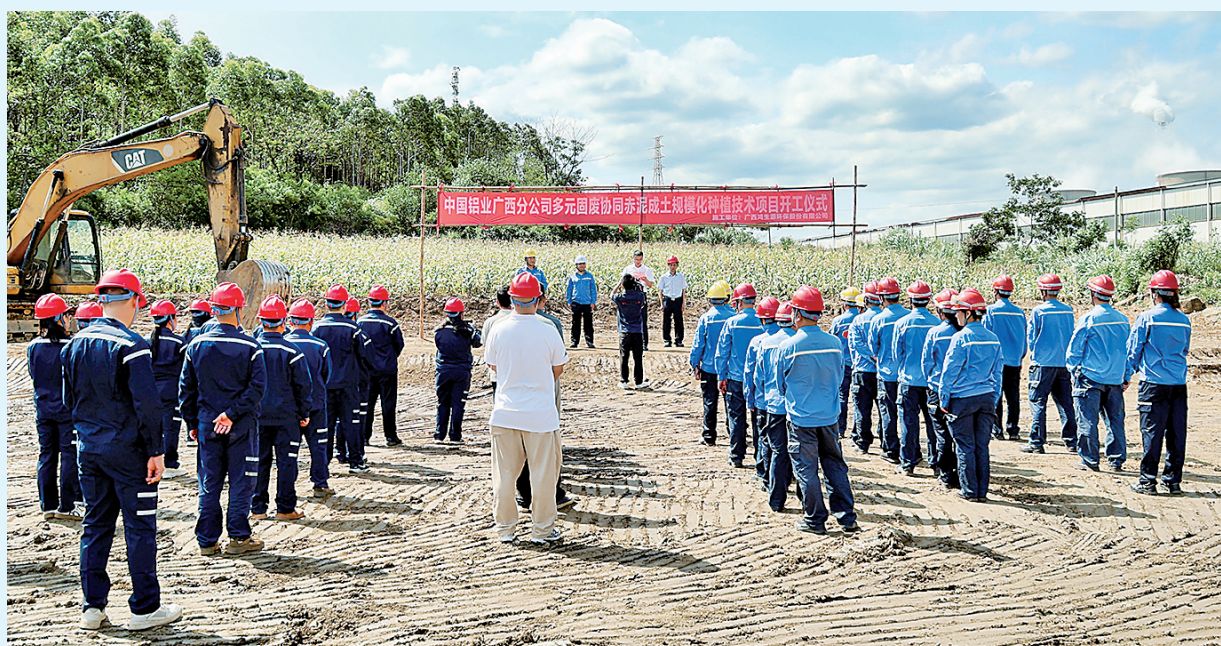
图为项目开工现场。
